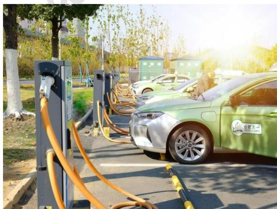
充电桩按其充电方式可分为：直流充电桩、交流充电桩和交直流一体充电桩。
